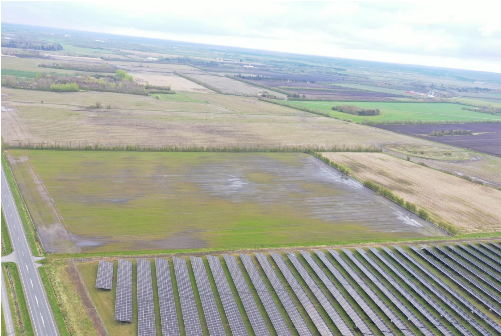
Kjelstrup Sol II, østlige matrikler. Billedet er taget 24.04.2024.
